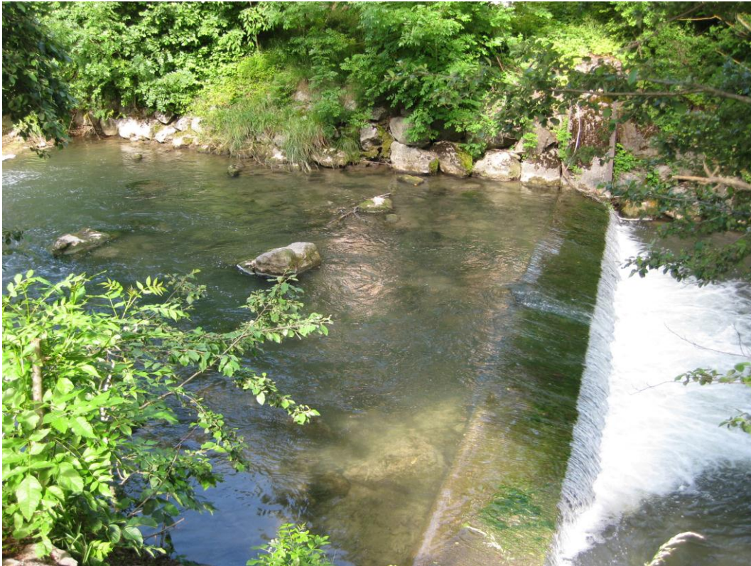
Foto 13: Fischwanderungshindernisse in Belp Mülimatt Km 5.800
