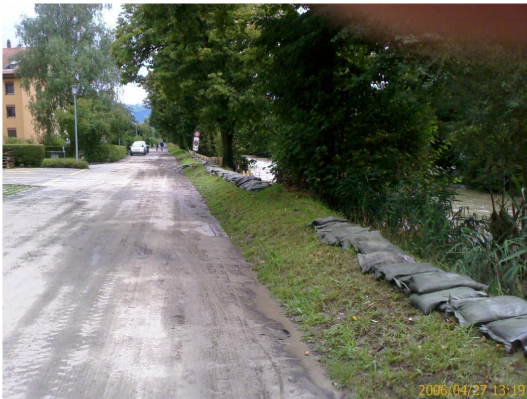
Foto 8: Rechtes Gürbeufer in Toffen, ob Bahnhofbrücke Km 8.800
