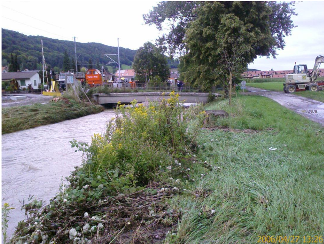
Foto 7: Erlenbrücke in Toffen Km 9.300, beim Hochwasser 2007
