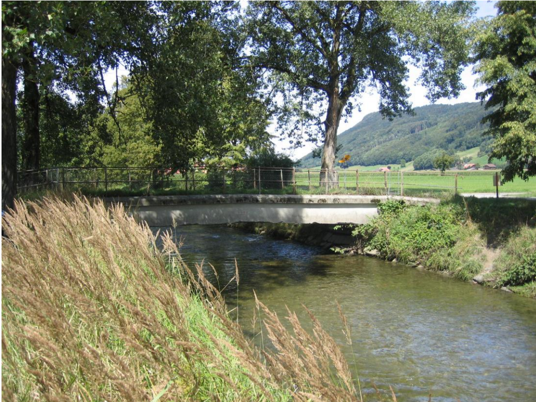
Foto 6: Erlenbrücke in Toffen Km 9.300, Blick flussabwärts
