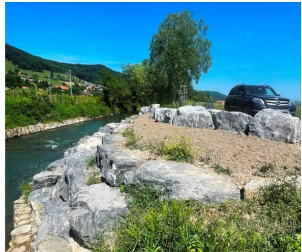
**Engstelle beim Streichwehr Toffen: Links erodiert nach zwei Hochwassern (Januar 2023), rechts saniert und mit Blöcken verstärkt (Juni 2023)**
