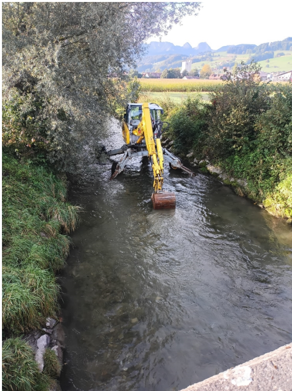
Niederwasserrinne Mühlethurnen (September 2024)
