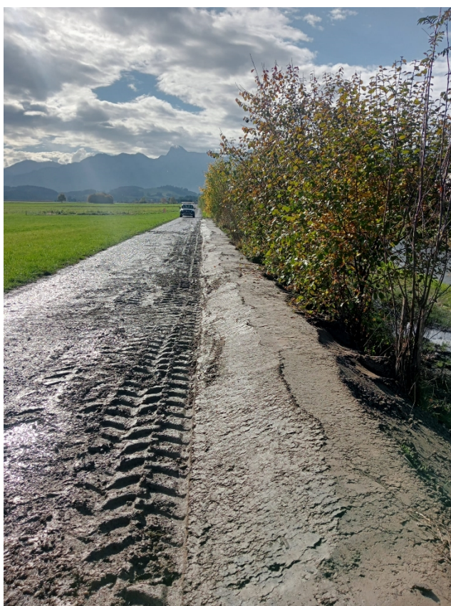
Damm in Mühlethurnen aufgeschüttet (Oktober 2024)
