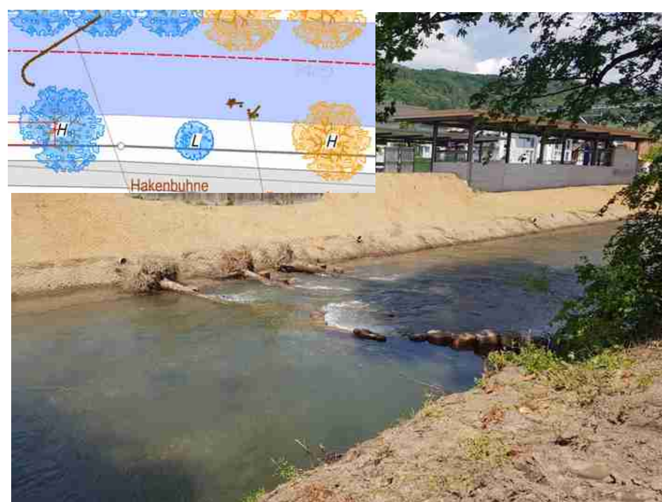
Abbildung 2: Hakenbuhne Situation und Foto der Ausführung
