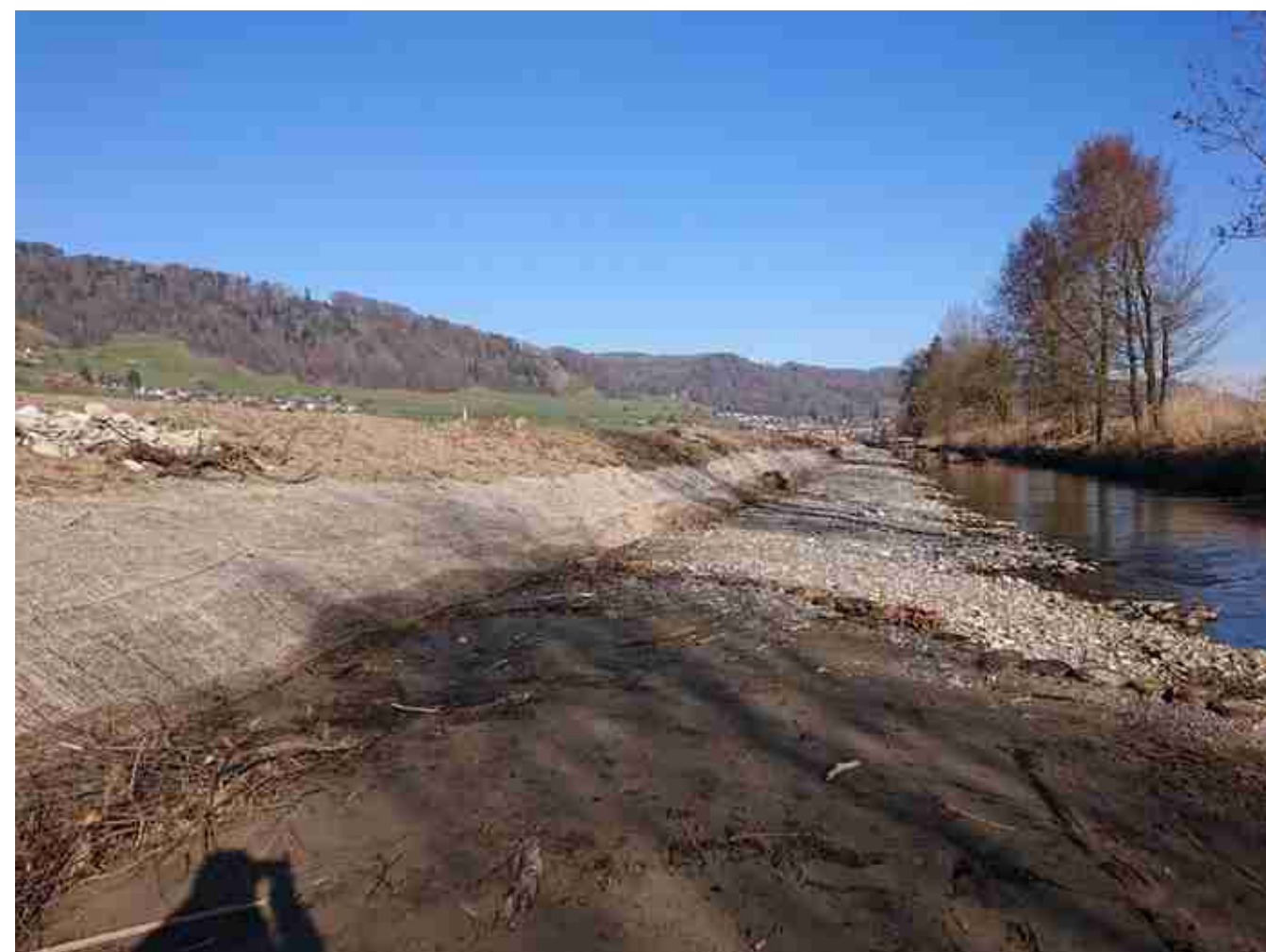
Abbildung 2: Gürbeverbreiterung mit Vorland zwischen der ARA und der Mündung Kaufdorfkanal - Foto
