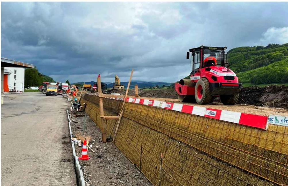
*Damm Ostseite Industriegebiet Allmend bei Firma Trösch – die Steilböschung des um rund 1m erhöhten Flurwegs wird mit einer begrünbaren TerraMur gesichert (Mai 2021)*
