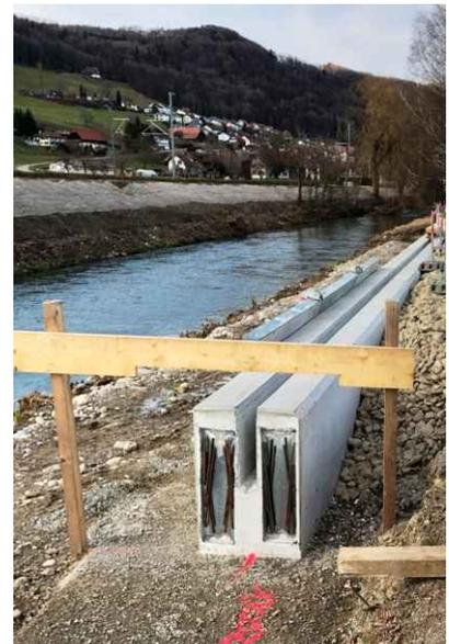
***Streichwehr im Bau – in der Mitte ist die Nut zum Einsetzen der Abflusskanten-Elemente sichtbar (Februar 2021)***
