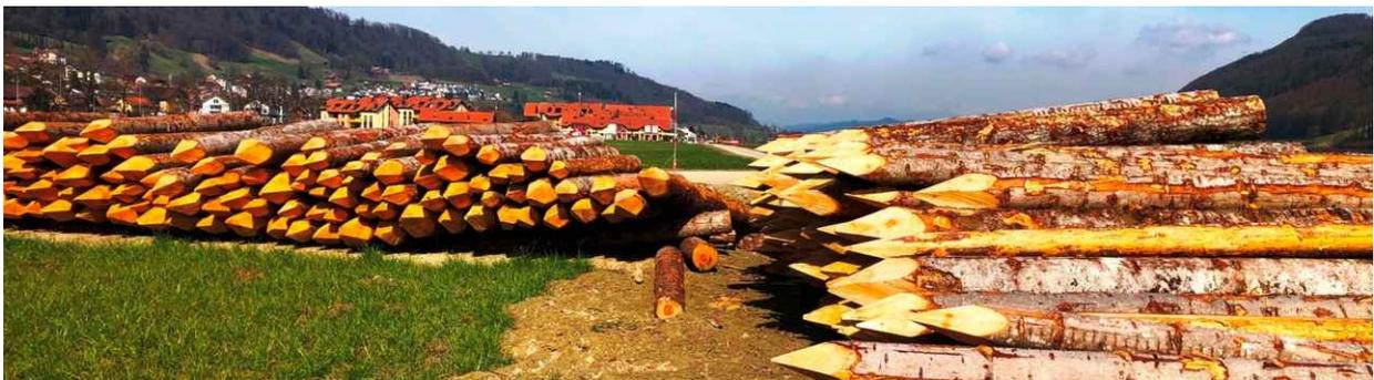
*Hunderte von Pfählen liegen auf dem Installationsplatz in Toffen bereit für den Einsatz als Strömungselemente, Böschungssicherung oder Leitungsfundamente (März 2021)*
