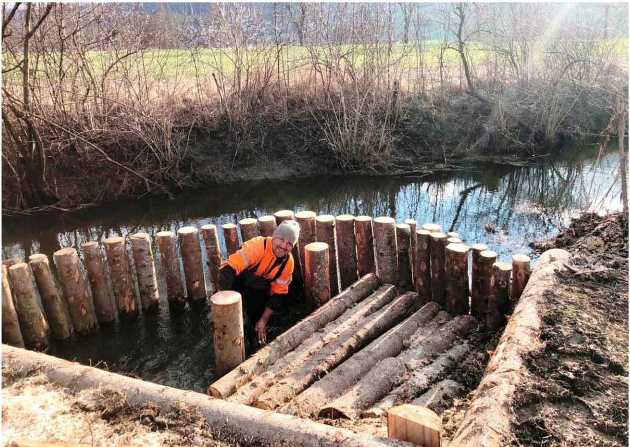
*Holzpalisaden zum Schutz der Entlastungsleitung bei der Müschemündung (März 2021)*
