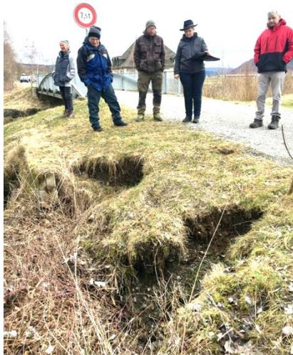
Der WGM ist vor allem durch Böschungsschäden betroffen (aktuell bei der Mündung des Lehen-Kanals in Kehrsatz sowie am Ahornweg in Belp). In der Regel werden solche Schäden gemeinsam mit den jeweiligen Grundeigentümern behoben.
