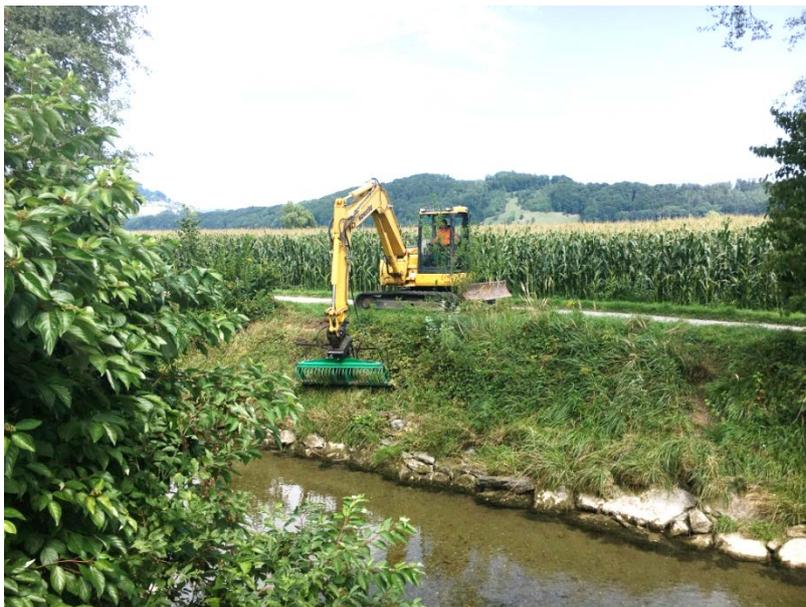
*Sommerlicher Böschungs-Unterhalt durch den Schwellenmeister an der Gürbe mit Hydraulikmäher und Fangkorb (Mühlethurnen, August 2017)*
