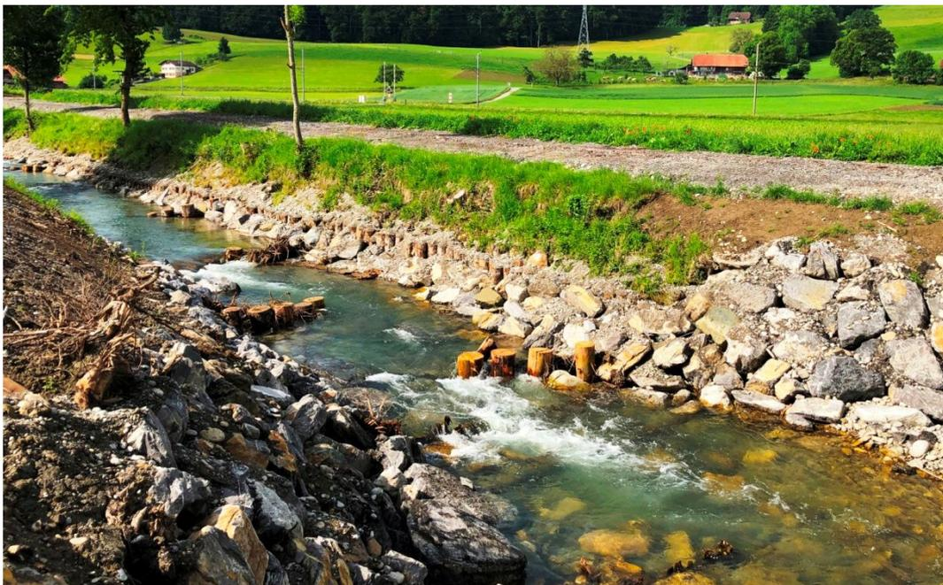
*Belebung des Niederwassers mit wechselseitigen Pfahlbuhnen bei Lohnstorf (Juni 2019)*
