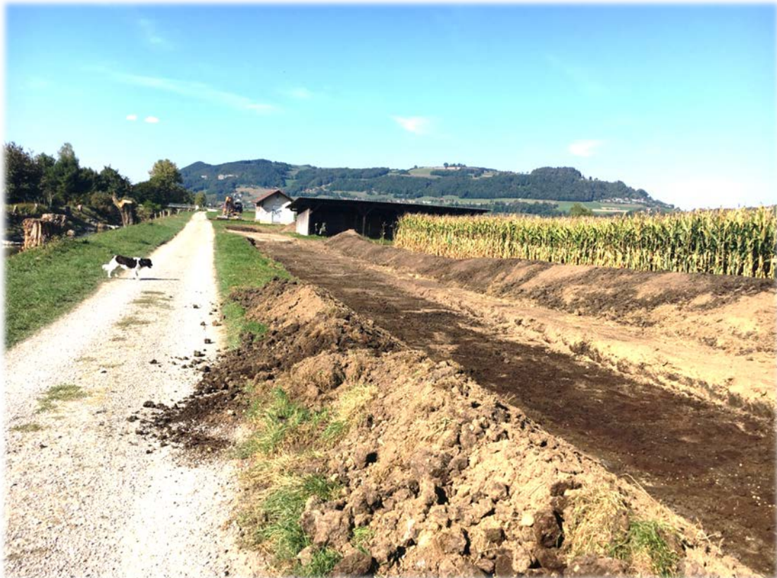
Der bisherige Gürbeweg (links) und das Trasse des neuen Uferwegs (rechts) zeigen das Ausmass der Gerinne-Verbreiterung im Bereich Mühlethurnen (20. September 2018)
