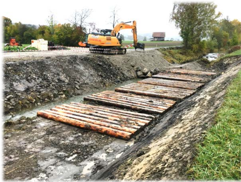
Bagger-Matratzen verhindern das Verdichten des Bodenmaterials (27. Oktober 2018)
