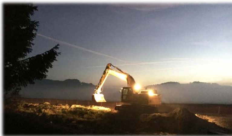
HWSuG – die Arbeiten starten schon vor dem Hellwerden (25. Oktober 2018)
