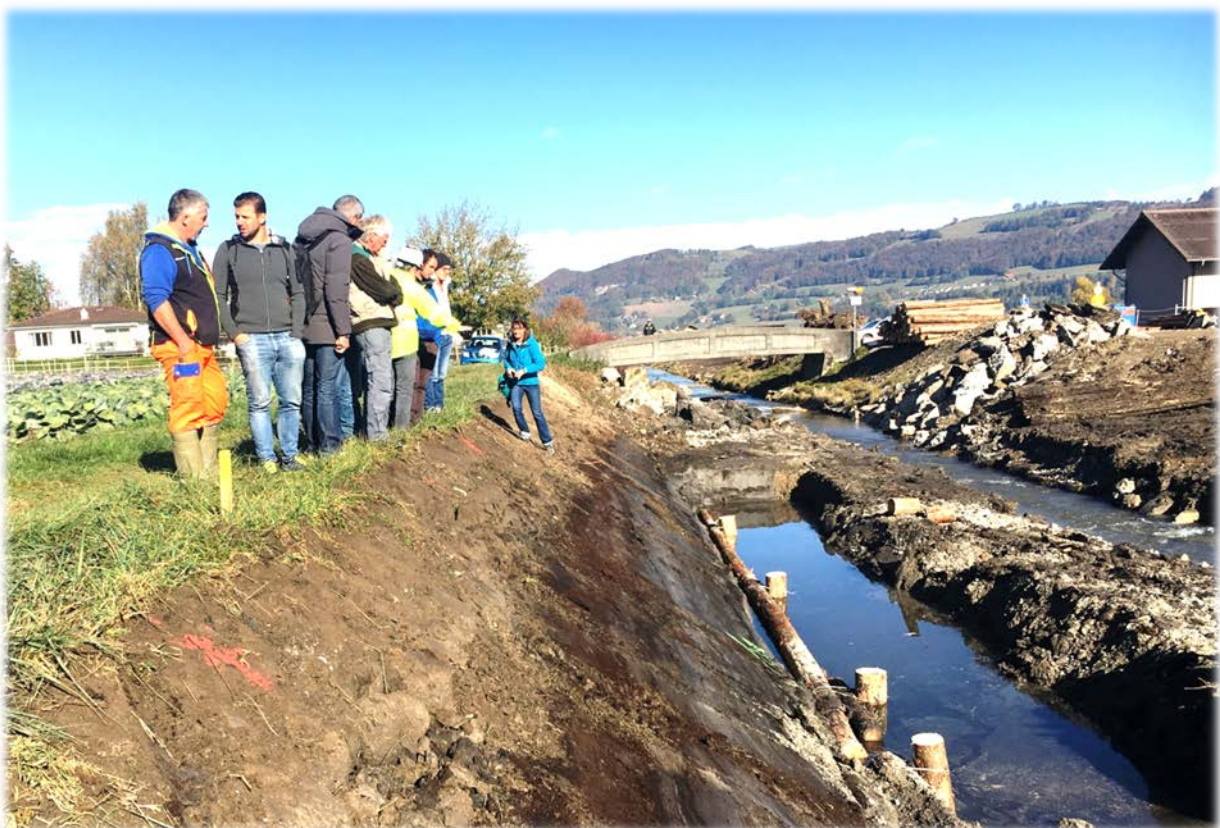
Abnahme Musterstrecke der Uferverbauung (1. November 2018)
