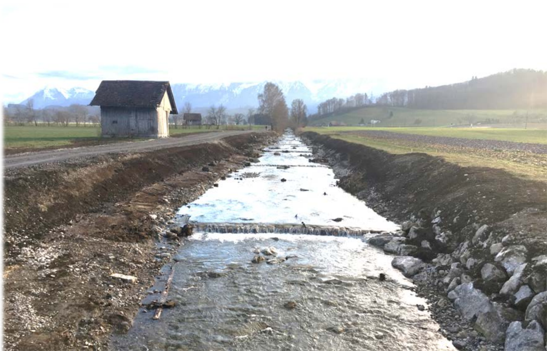
Neues breites Gerinne ob Madbrücke Mühlethurnen – verschiedene kleinere Sperren ersetzen die abgebaut und nicht fischgängige Meitschibad-Schwelle (31. Dezember 2018)
